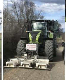
Arasement d'accotements à gauche, ensuite scarification puis damage des gravillons.
